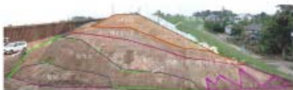
図 3-11 堤防の横断断面 鳴瀬川 12.2km 右岸
