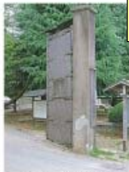
写真 2-6 小川閘門の扉 (鳴瀬川の治水を助ける目的で明治 39 年に設置された小川閘門の扉)
