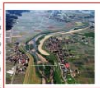
写真 3-8 鳴瀬川の低水路砂州の状況
