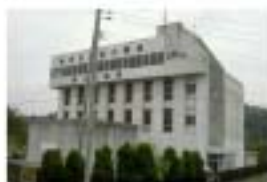
写真 3-6 新築五郎排水機場(昭和 55 年完成)
