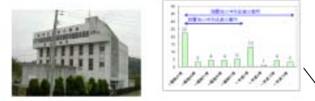
写真 3-6 静観五郎取水機場(昭和 55 年完成) 図 3-13 河川管理施設の設置箇所数
