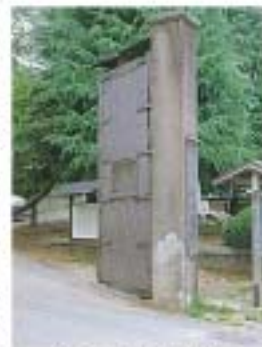
写真 2-8 小川閘門の扉 (鳴瀬川の治水を助ける目的で明治 39 年に設置された小川閘門の扉)
