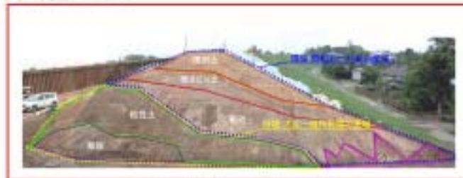
図 3-11 堤防の横断断面 鳴瀬川 12.2km 右岸
