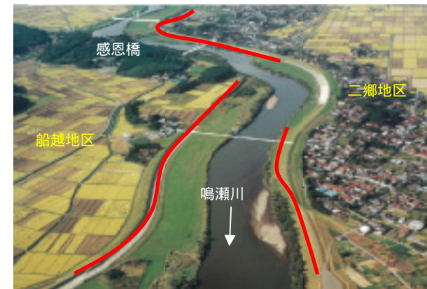
鳴瀬川左岸：二郷地区、鳴瀬川右岸：船越地区 (断面不足箇所)
