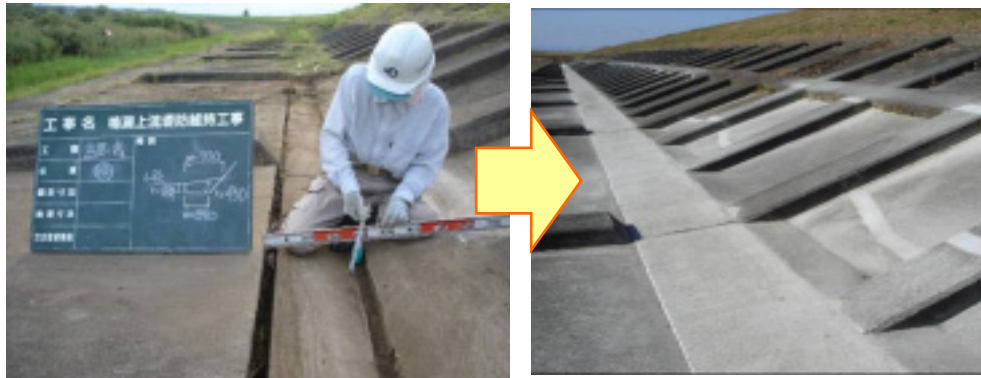
高水護岸の補修状況
