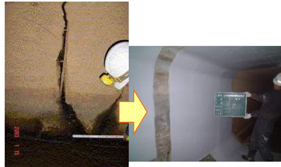
樋門の補修状況
