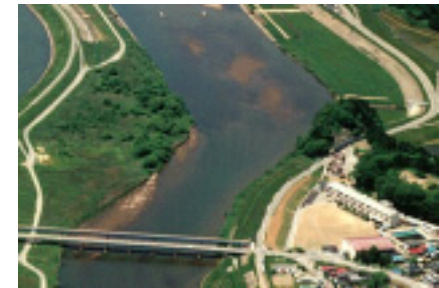
鳴瀬川の高水敷の状況
