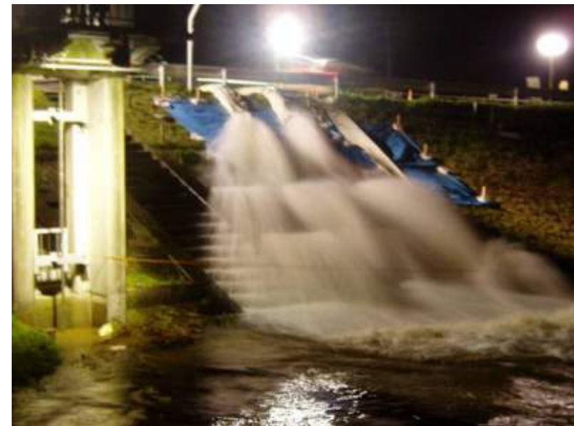
東松島市宿浦地内での 内水排除状況(平成18年10月洪水)
