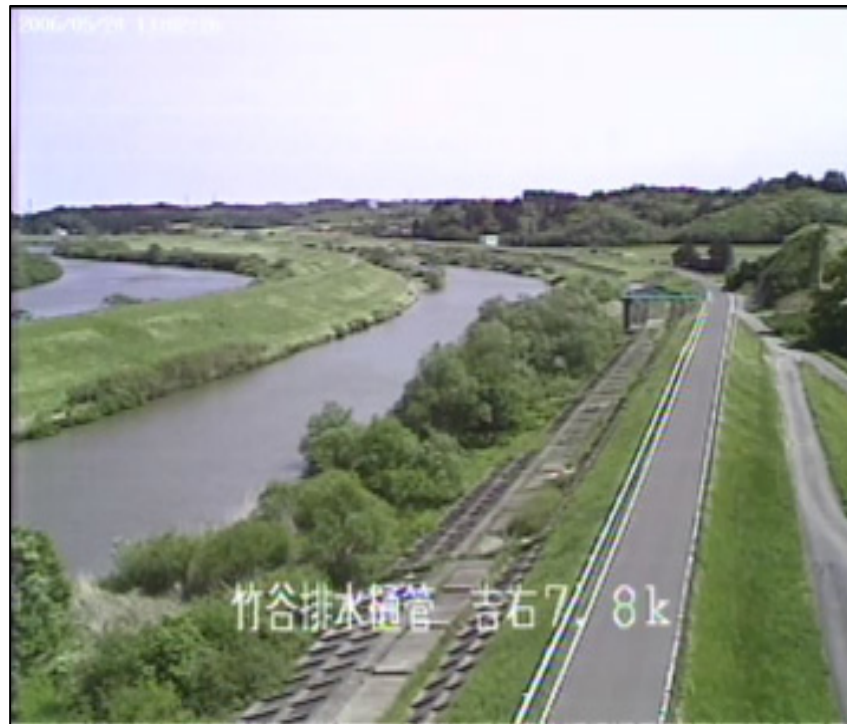
ホームページ上に公開されている河川情報カメラの画像
