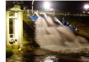
排水ポンプ車稼働状況
