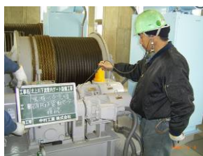
河川管理施設の点検
