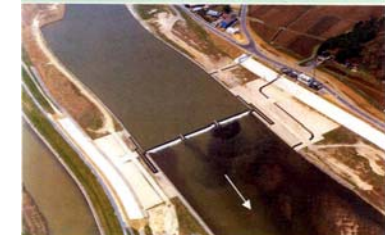
鳴瀬堰(H2完成)
