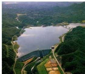
南川ダム(S62完成)
