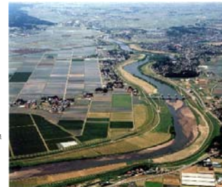
鳴瀬川中流堰(H14完成)
