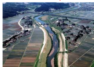
桑折江頭首工(H15完成)
