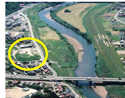
防災ステーション (大崎市三本木)
