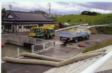
平成14年月洪水(三本木町百件堀排水樋管)
