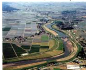
鳴瀬川中流堰(H14完成)
