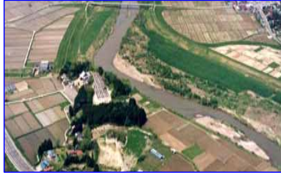
中流部の状況（39Km付近）
