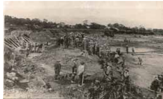
明治43年8月洪水（鳴瀬川三本木） 鳴瀬川の堤防決壊箇所を修復する様子
