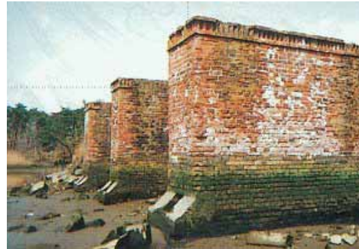
野蒜築港計画で建設された橋脚 (北上川下流河川事務所資料)
