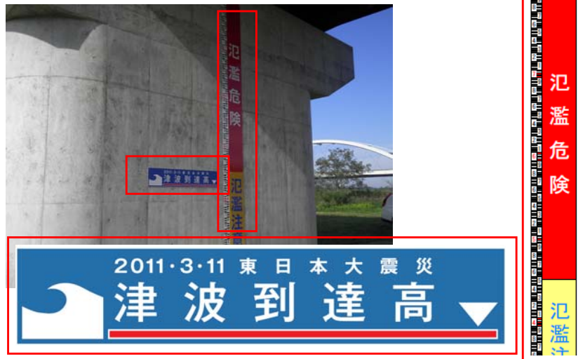
橋脚への表示板設置事例 (鳴瀬川：東松島大橋)
