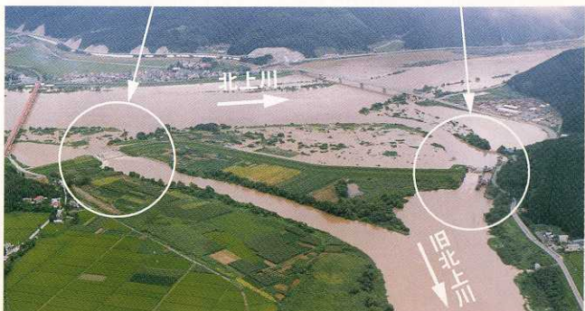
洪水時の鴨波洗堰及び脇谷洗堰からの分流状況
