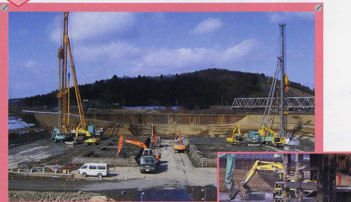
地盤改良工事
