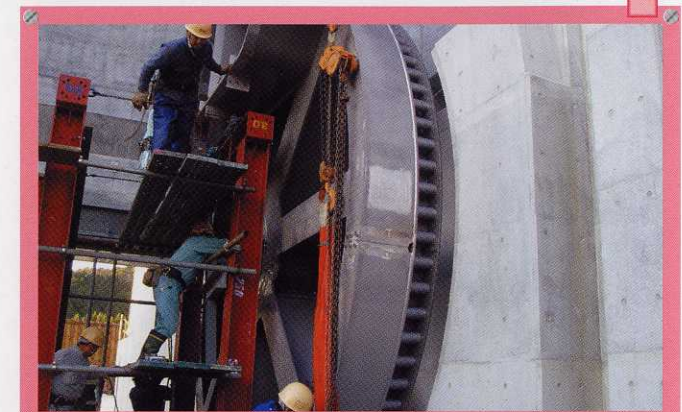
ゲート据え付け
