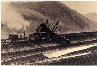
新川柳崎掘削工事(桃生町)
