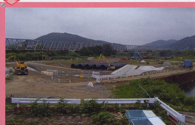
本体工事のため水路を付け替える
