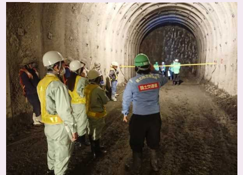
【鳴瀬川ダム事業(仮排水トンネル)】
