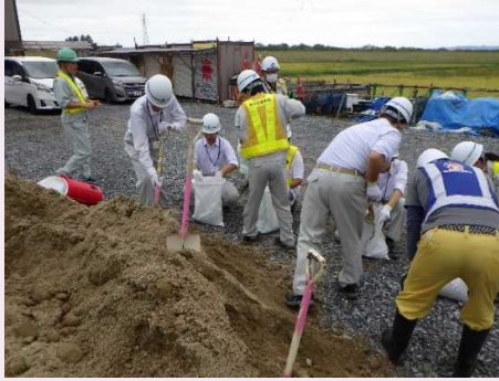
【河川維持工事(土嚢づくり)】
