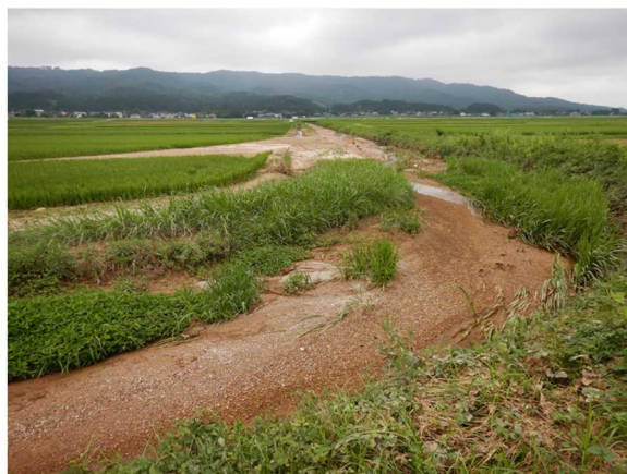
最上川右岸支川(竹田川)の被災状況
