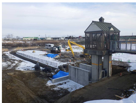
樋管ゲート改修工事 施工中
