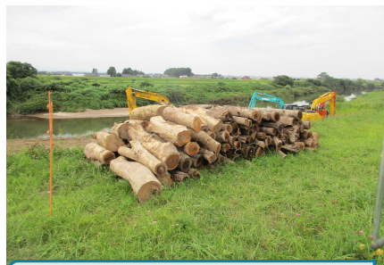
提供する伐採木仮置き状況
