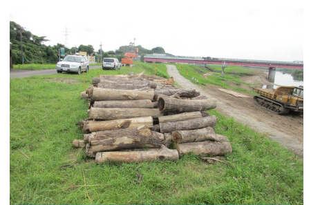
提供する伐採木仮置き状況
