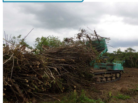
樹木伐採施行中
