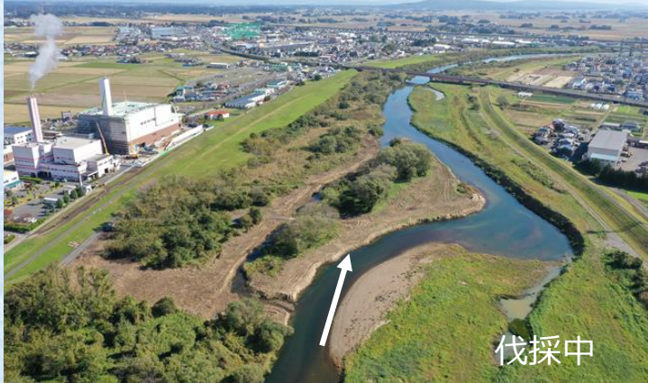
江合川左岸 桜ノ目地区
