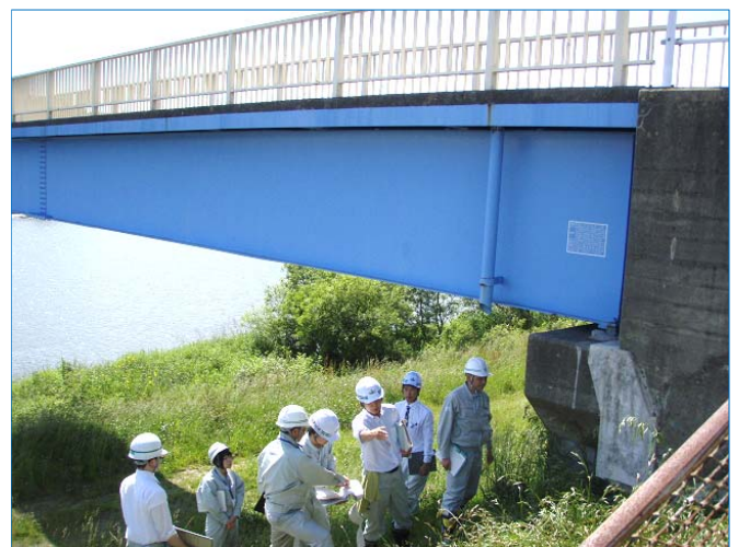
点検状況（小野歩道橋：東松島市）
