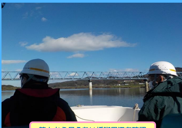
陸上から見えない橋脚周辺を確認
