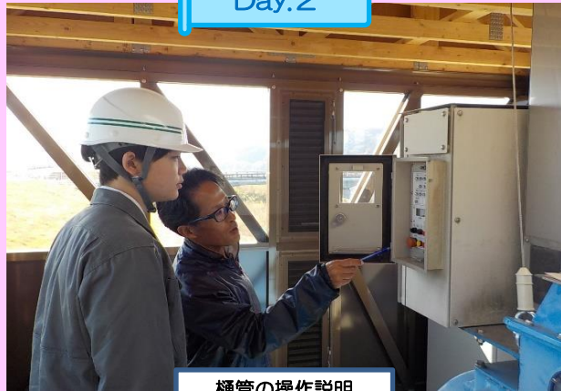
樋管の操作説明
