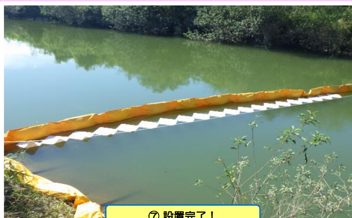
⑦ 設置完了!
