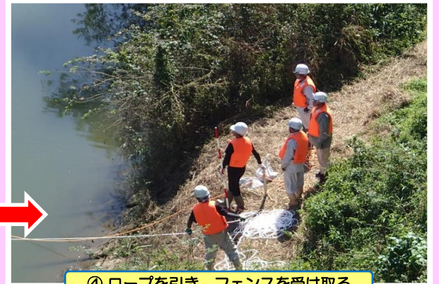
④ ロープを引き、フェンスを受け取る
