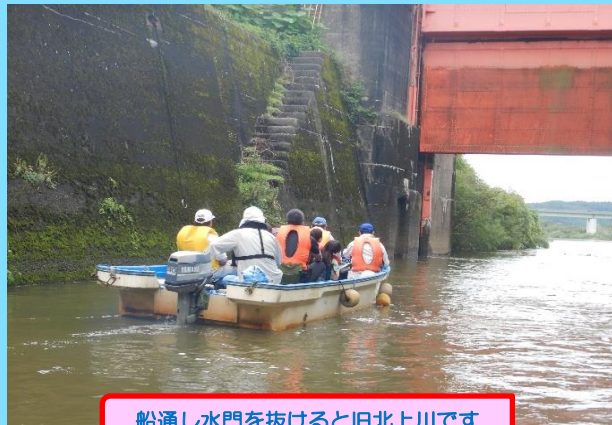
船通し水門を抜けると旧北上川です
