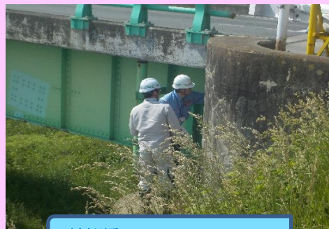
錦桜橋 施設管理者：宮城県
