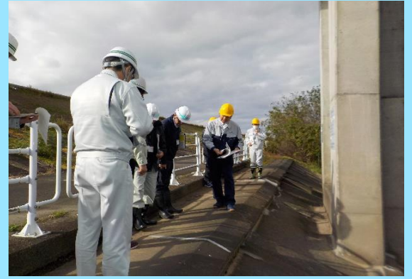
護岸ブロックの状況確認
