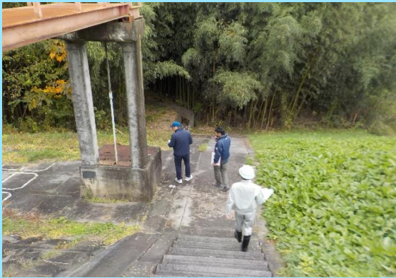
取水口の状況確認
