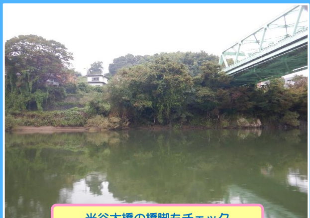
米谷大橋の橋脚もチェック
