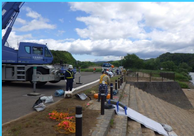
ホースを延ばし、接続していきます
