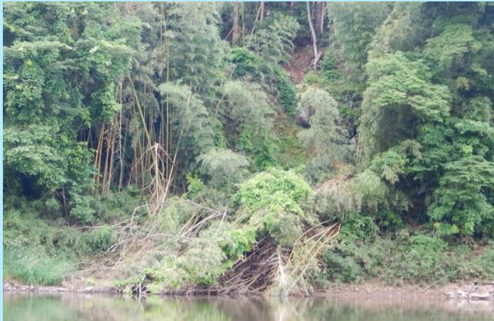
船上から確認した法崩れ箇所
