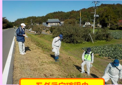
モグラ穴確認中
