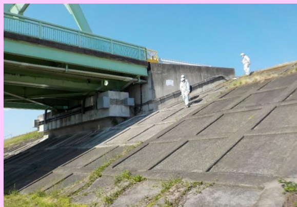
米谷大橋 施設管理者：宮城県
