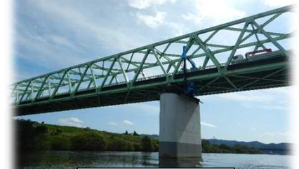
橋脚周辺の点検
