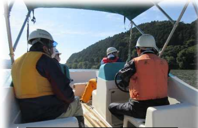
水際付近の護岸の点検
