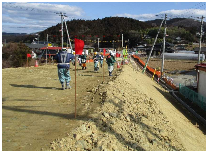
現場内点検状況
