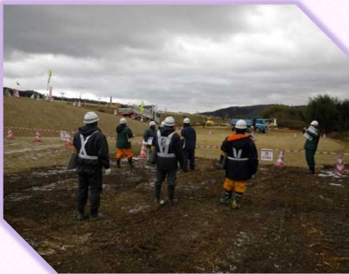
▲工事現場、重機作業をパトロール
