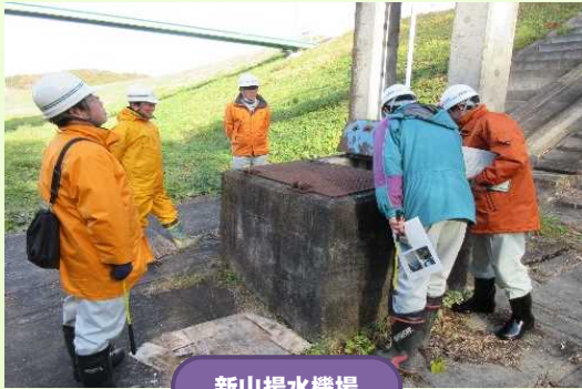
新山揚水機場
