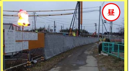
2 登米保育所前の工事現場
