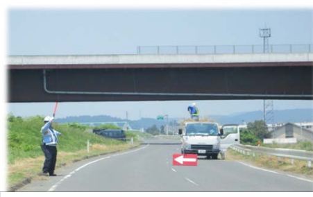
道路近くの作業では、交通誘導により安全確保しているので、ご協力のほどお願いします。
