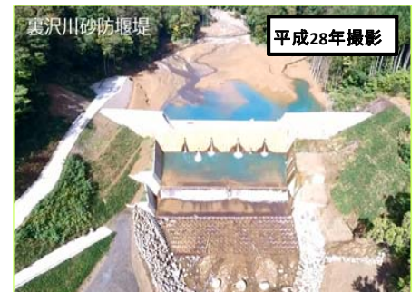
▲ 下流への土砂流出を防止する砂防堰堤を新設 (裏沢川砂防堰堤)
