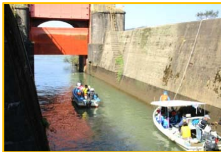
脇谷洗堰の閘門(船通し水門)を通過
