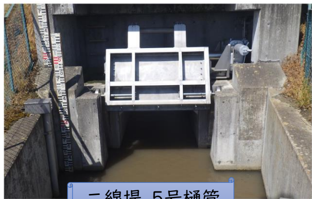
二線堤 5号樋管
