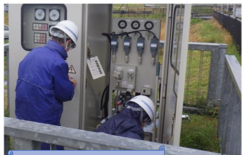
二線堤 1号樋管
