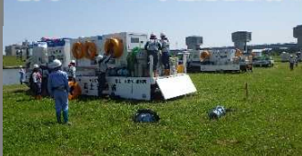
排水ポンプ車点検開始！
