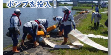
ケーブルを接続して ポンプを投入！
