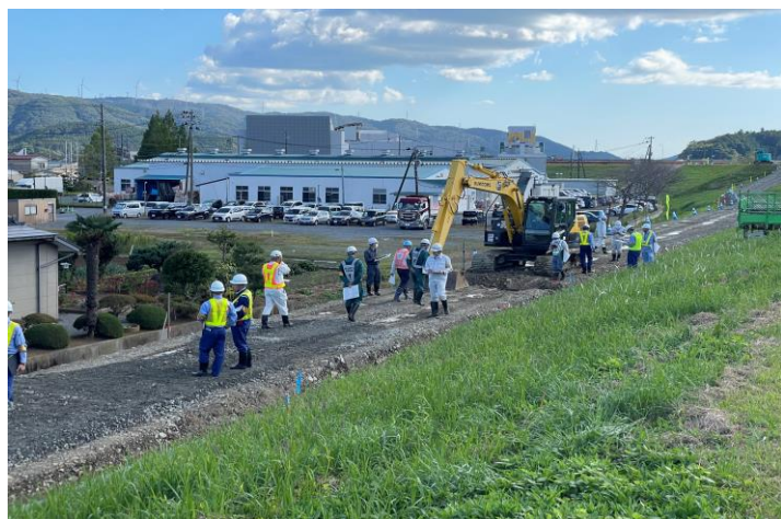
↑①工事のパトロール様子（相野谷地区堤防付近）
