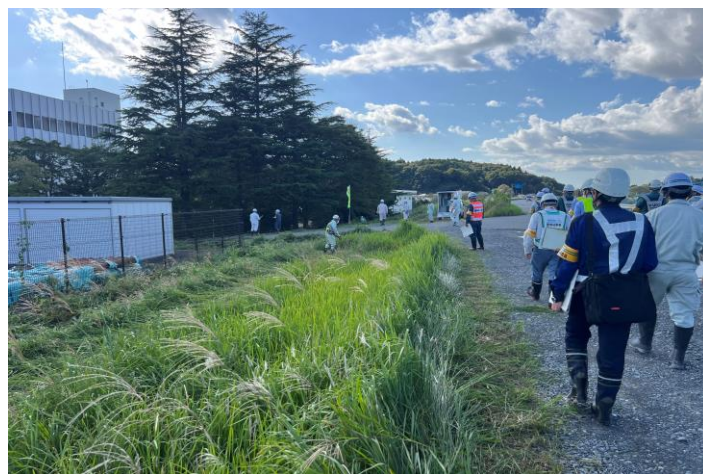
↑②工事のパトロール様子（追波川排水機場付近）
