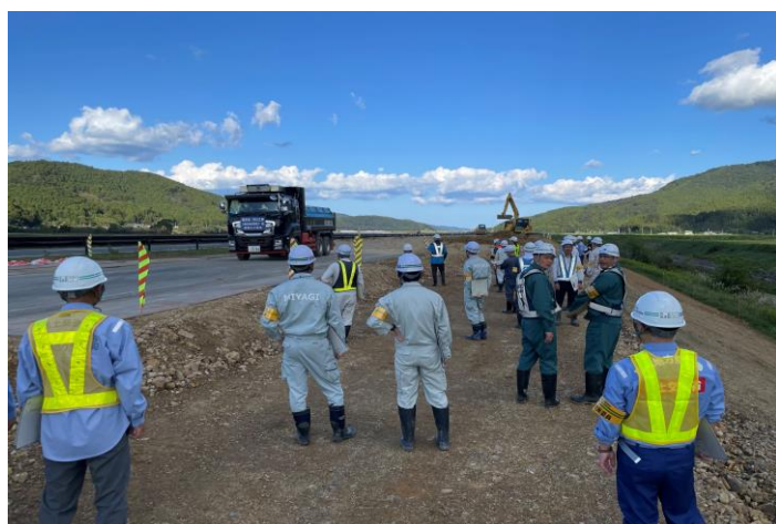
↑③工事のパトロール様子（三輪田地区堤防）
