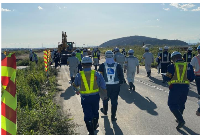
↑④工事のパトロール様子（三輪田地区堤防）
