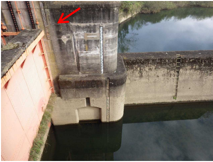
◀脇谷閘門 設置前↑
