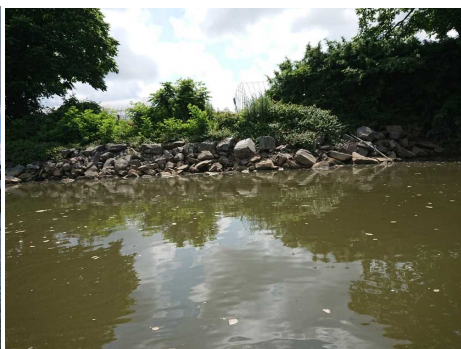
◀旧北上川 河岸状況（捨て石護岸）
