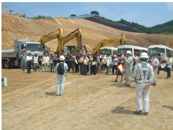
▲工事概要の説明(手代森トンネル盛岡側坑口)
