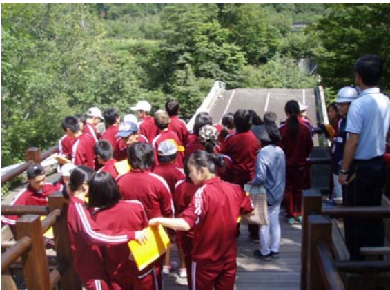
落橋した「祭時大橋」を見学し、岩手・宮城内陸地震の被害の大きさを実感しました。
