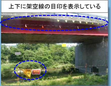
上下に架空線の目印を表示している
