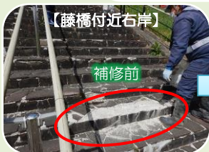
階段の鉄平石の破損
