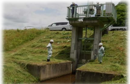
～*～*～ ・ 排水樋管の点検状況 ・～*～*～
