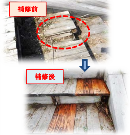
破損した箇所の木材を張替ました
