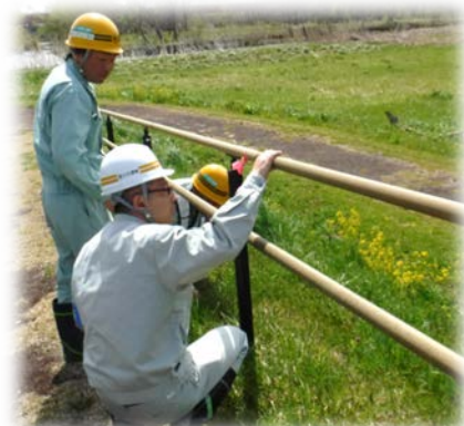
手すりにゆがみ等が無いかも確認！！
