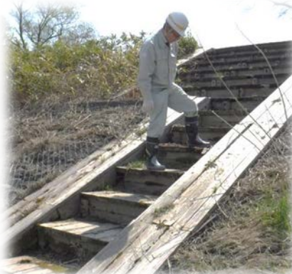
階段も隅々まで点検中・・・
