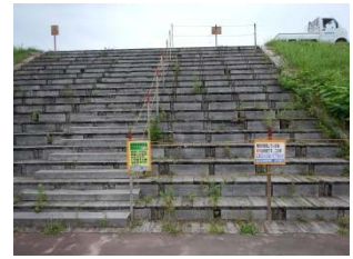
応急措置実施 (珊瑚橋下流・木製階段)
