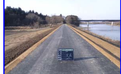
復旧工事完了
