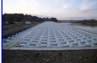
大型ブロック設置状況
