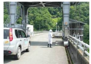
ダム堤体巡視
