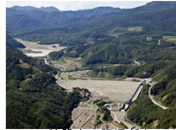
建設中の胆沢ダム (平成 24 年 10 月撮影)
