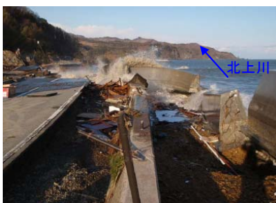
北上川右岸-0.2k付近(石巻市月浜地先) ※津波により堤防が流出
