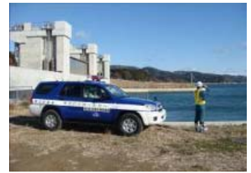
河川巡視状況
