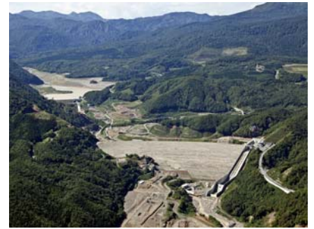
建設中の胆沢ダム (平成 24 年 10 月撮影)
