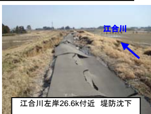
江合川右岸26.6k付近 堤防沈下
