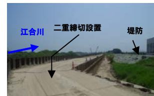
本復旧工事 実施状況 (H24.7.30撮影)
