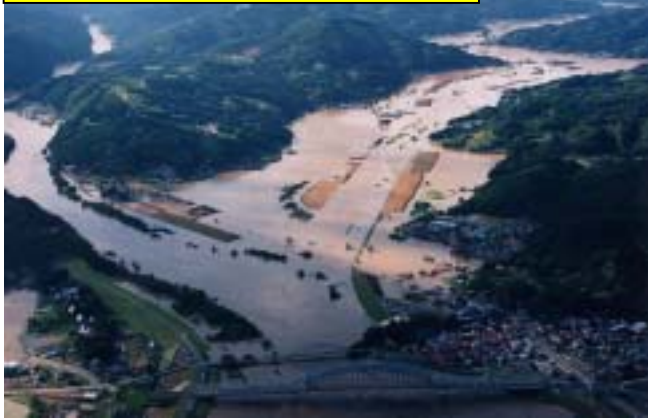
H14.7洪水浸水状況(下流地区)
