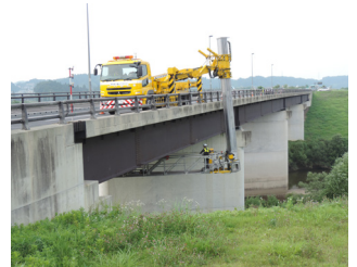
橋梁定期点検
