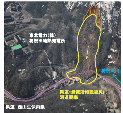
葛根田川で発生した大規模崩壊
