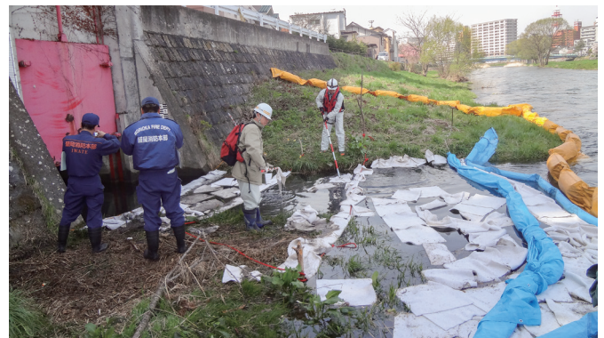
流出した油の処理
