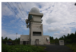
レーダー雨量観測所
