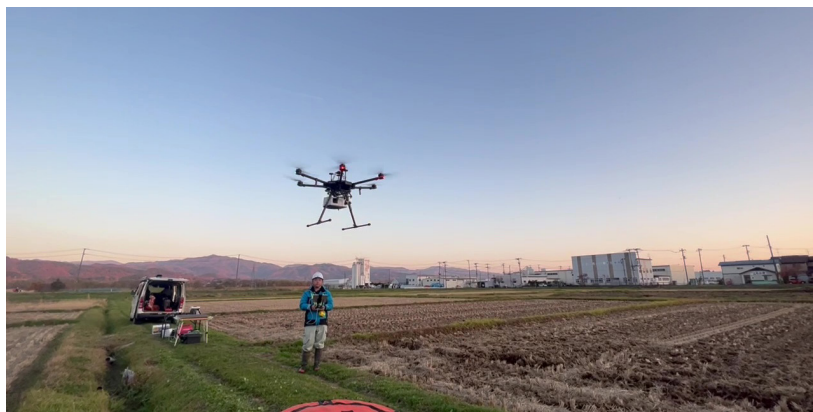
UAVによる路線測量(盛岡南道路)
