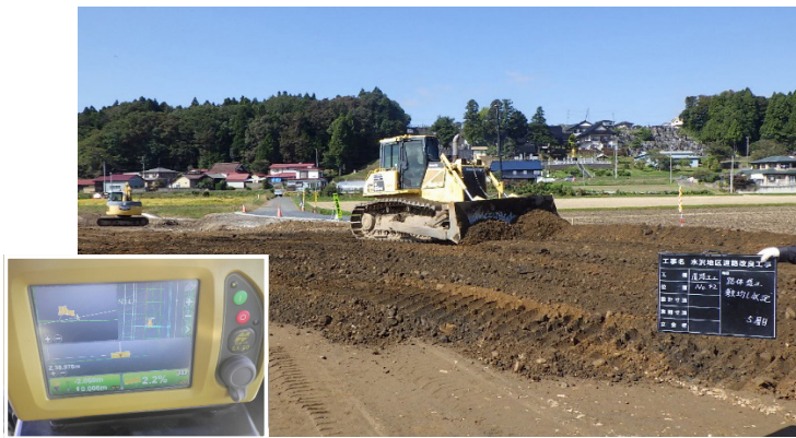
ICT建設機械による盛土施工
