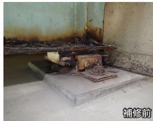
橋梁補修(主桁補修工、支承取替工)
