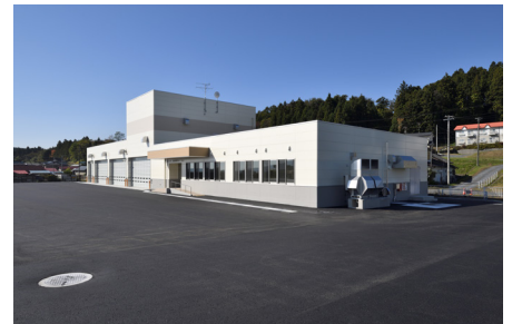
防災除雪ステーション(R5.11完成)
