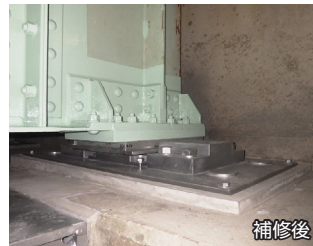
橋梁補修(主桁補修工、支承取替工)
