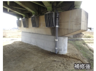
橋梁耐震補強 (横変位拘束構造)
