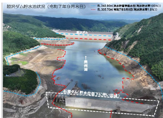
胆沢ダム貯水池の状況（令和7年9月8日撮影）
