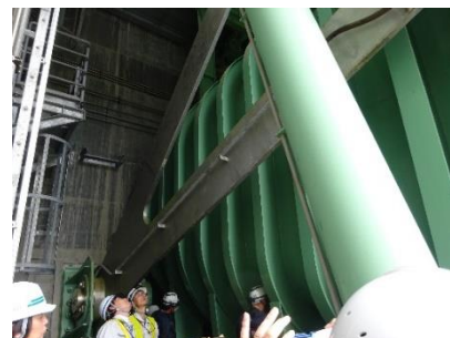
▲変形がないか目視点検をします
